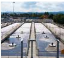
Plantas de Tratamiento de Agua
